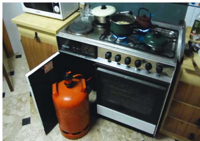
Использование газового баллона с превышенной литражностью в качестве дополнительного источника для плиты комбинированного типа. Кухня жилого многоквартирного дома. Фото из сети Интернет.
