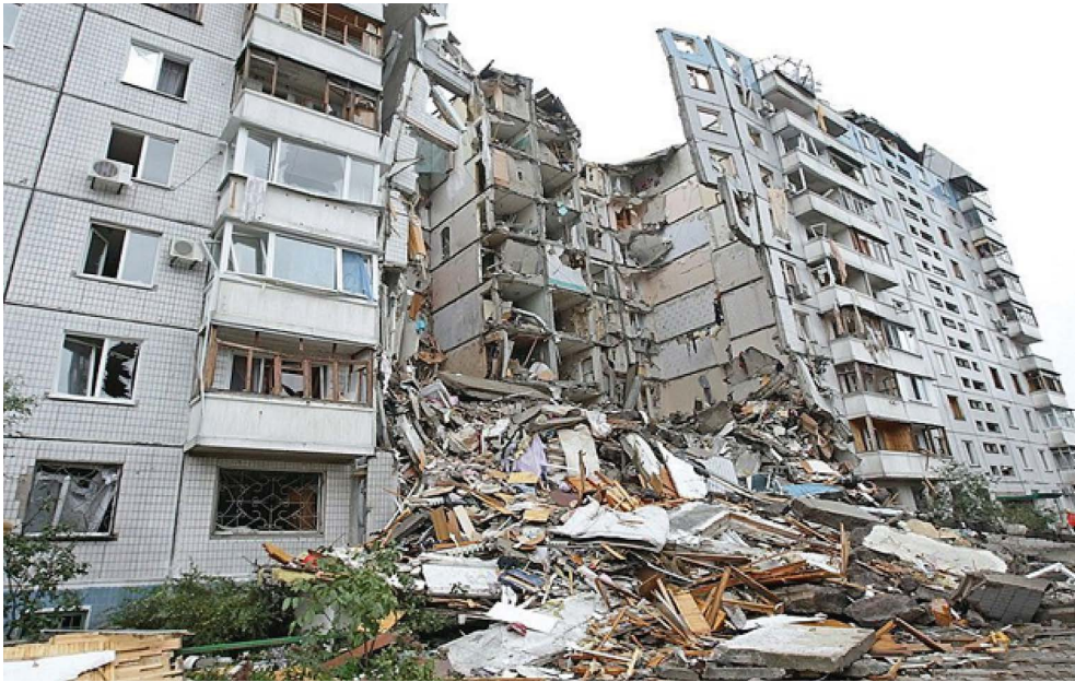
Последствия взрыва газовоздушной смеси в жилом многоквартирном доме в г. Днепрпетровске 13 октября 2011 года.
