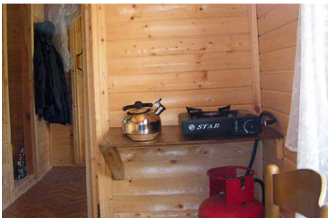
Установка газовой портативной плиты и баллона с газом на кухне индивидуального жилого дома с грубыми нарушениями требований нормативных правовых актов. Фото из сети Интернет.
