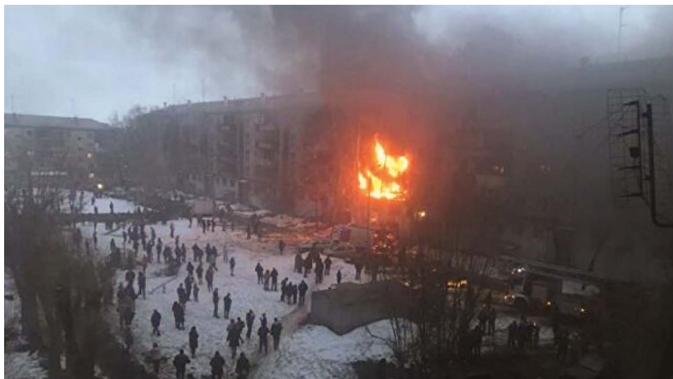
Возникновение и распространение пожара в результате взрыва газовой смеси. Жилой многоквартирный дом в г. Магнитогорске. 26 марта 2020 года.
