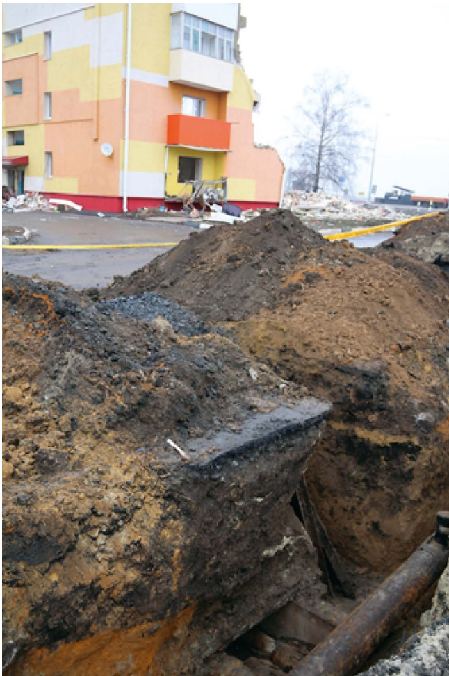
Вид на дом со стороны места врезки отвода в газопровод.
