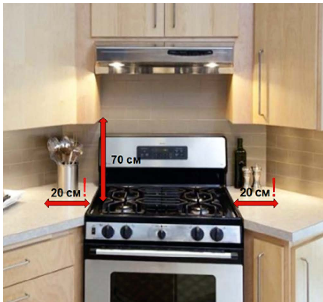
Минимальные расстояния от мебели и других горючих предметов по горизонтали и вертикали (до нависающих предметов) в соответствии с требованиями Правил противопожарного режима в Российской Федерации.
